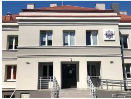
Wejście do komendy po remoncie
