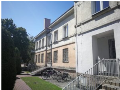
Komenda przed remontem
