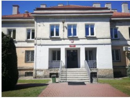
Wejście do komendy przed remontem
